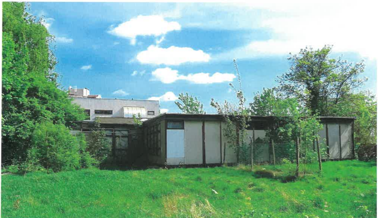
Fot. 3 Widok obiektu od strony południowej, maj 2024
