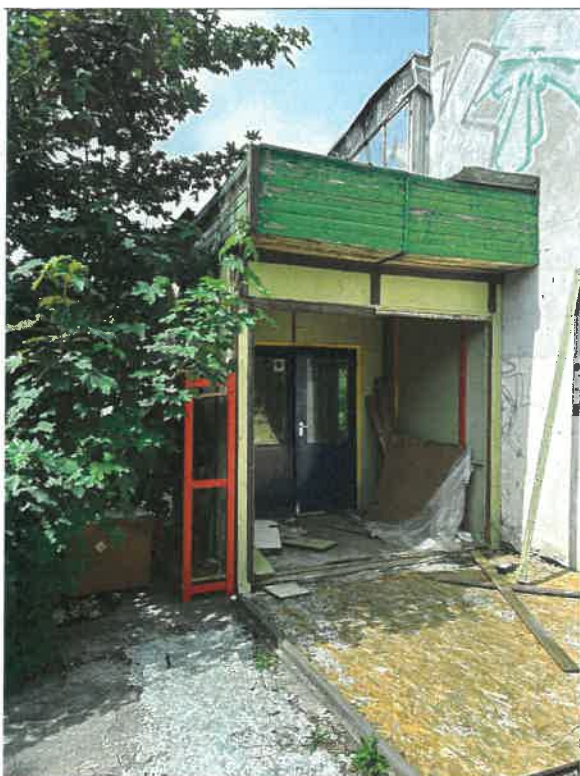
Fot. 4 Główne wejście do pawilonu, maj 2024
