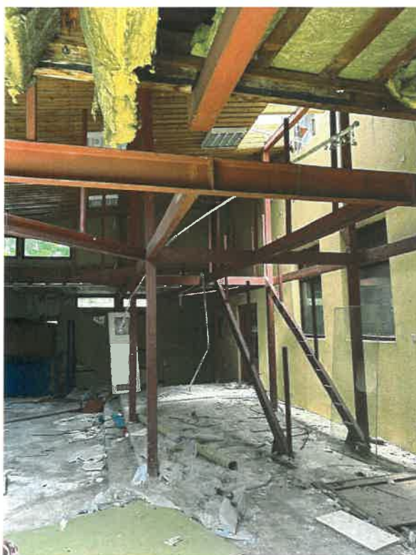
Fot. 6 Część pawilonu przylegająca do budynku szkoły, maj 2024
