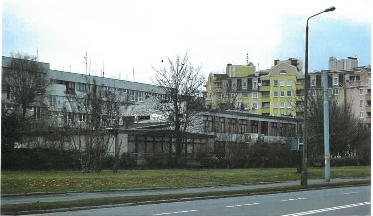
Fot. 2 Widok obiektu od strony wschodniej, kwiecień 2024
